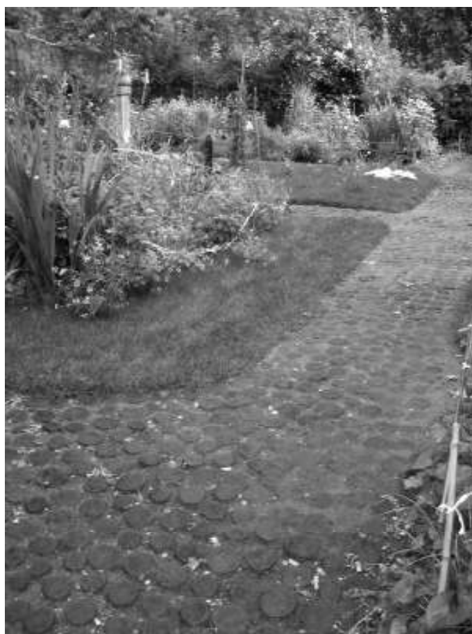
Fig. 9 – Pavimentazione del giardino in tronchetti di castagno infissi verticalmente nel terreno.
