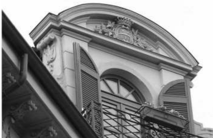
Fig. 2 - Particolare del prospetto verso via dei Mille.
