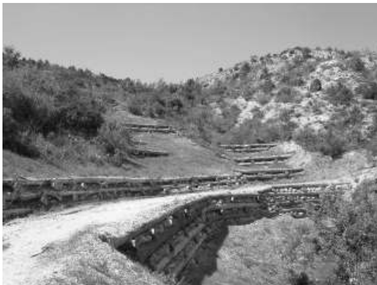
Fig. 11 - Palificate di sostegno alla strada e di stabilizzazione di calanchi, con attecchimento delle semine e degli arbusti.
