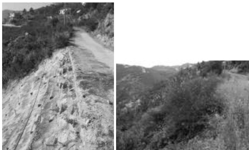
Fig. 8 - Sistemazione di frana sotto strada, con palizzate a doppia parete e grata viva, appena ultimata (a sinistra) e 6 anni dopo (a destra).
