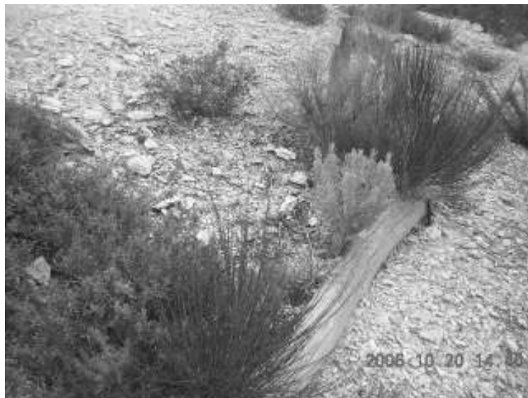
Fig. 9 - Palizzata semplice in legno di castagno, con impianto di arbusti autoctoni nel rinterro.
