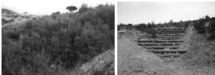
Fig. 6 - Sistemazione dei calanchi con palificate a doppia parete in legname di castagno scortecciato, a struttura appena ultimata (a sinistra) e 6 anni dopo (a destra).
