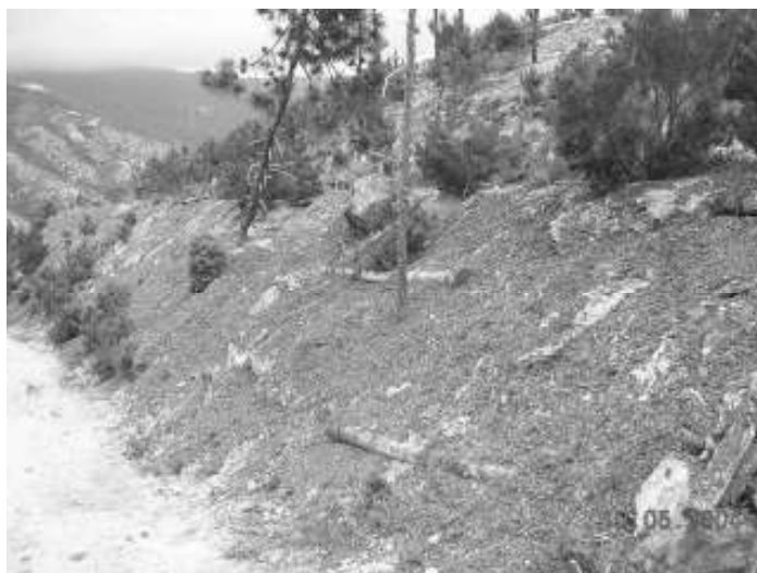
Fig. 13 - Apporto di cippato su versanti in erosione, stabilizzati con palizzate semplici.
