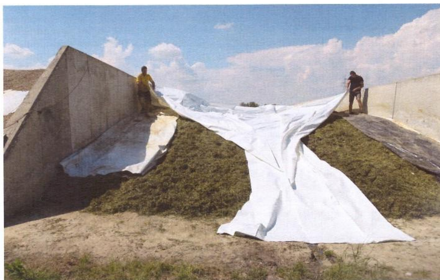
13 - Stesura del foglio di polietilene per la copertura dell'erba nel silo
